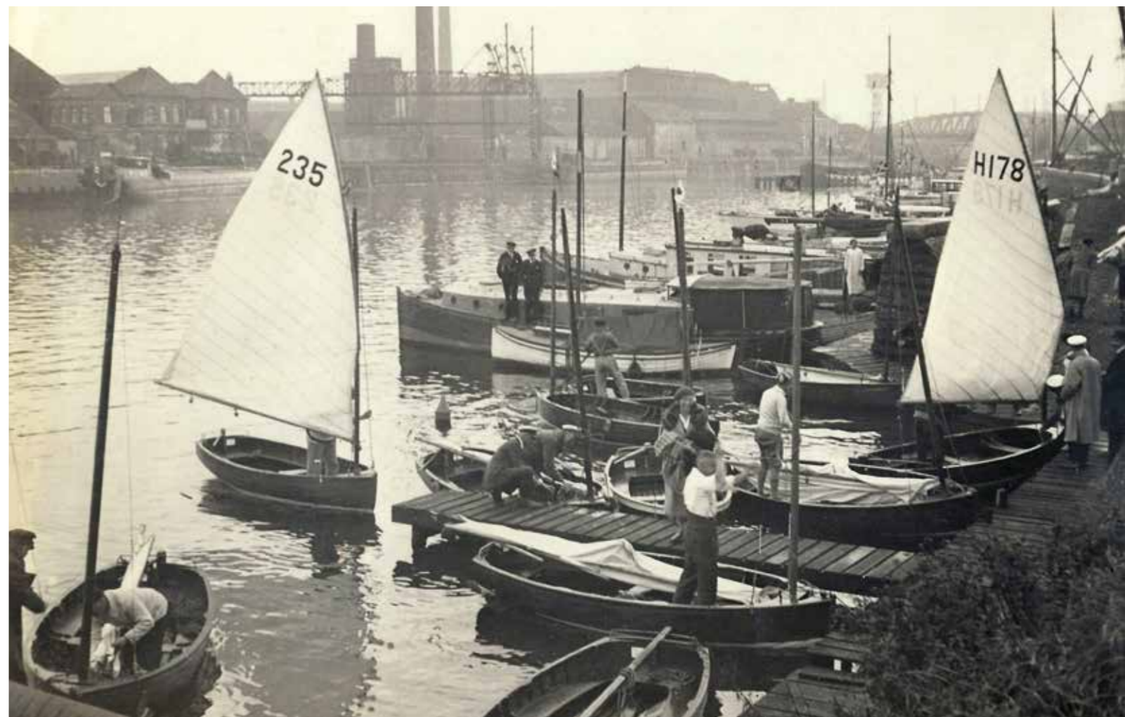
Tussen 1928 en 1930 trokken leden van Westend enkele keren naar Brussel om wedstrijd te zeilen. Vanwege de kosten bleven de jollen in Aalsmeer, alleen rondhouten en tuigen werden meegenomen. Zo ook van de H 178. FOTO: SCHEEPSWERFDEVLIJT.NL/JOLLEN-VAN-WESTEND-1927
